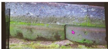
建屋を支える基礎石は、上層と下層になっているが、上層の延べ石を形状に合わせて加工する「光付け」が施され、石工の仕事に尊敬の念を抱くとともに、石工の情念すら感じとれる。
